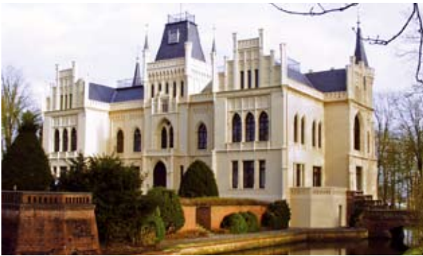
In der Pracht der Neugotik erstrahlt das Wasserschloss Evenburg in Leer-Loga nach umfassender Sanierung. Zinnen, Spitzen und Türmchen der stark gegliederten Fassade wurden im Steenfelder Betonwerk Johann Meinders GmbH gefertigt.
