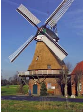
Nicht nur auf historischen Gebäuden ist das traditionelle Reetdach ein schöner Blickfang.
