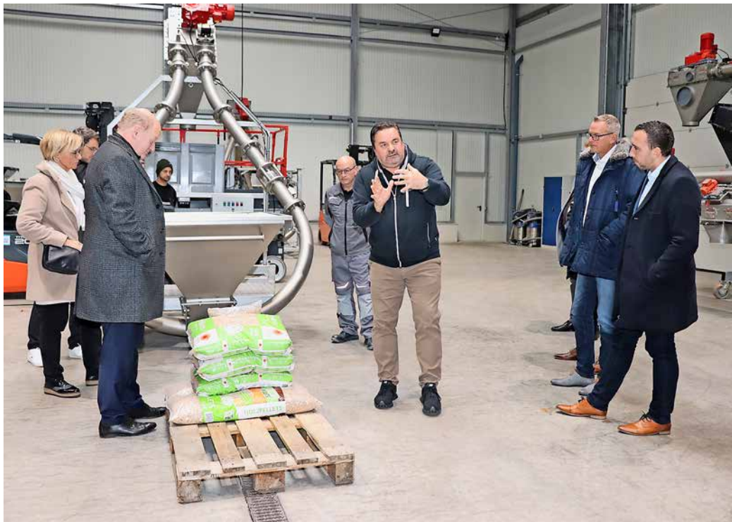
Ralf Schrage (Mitte) erklärte den Gästen den Aufbau und die Funktionsweise eines Rohrkettenförderers.
